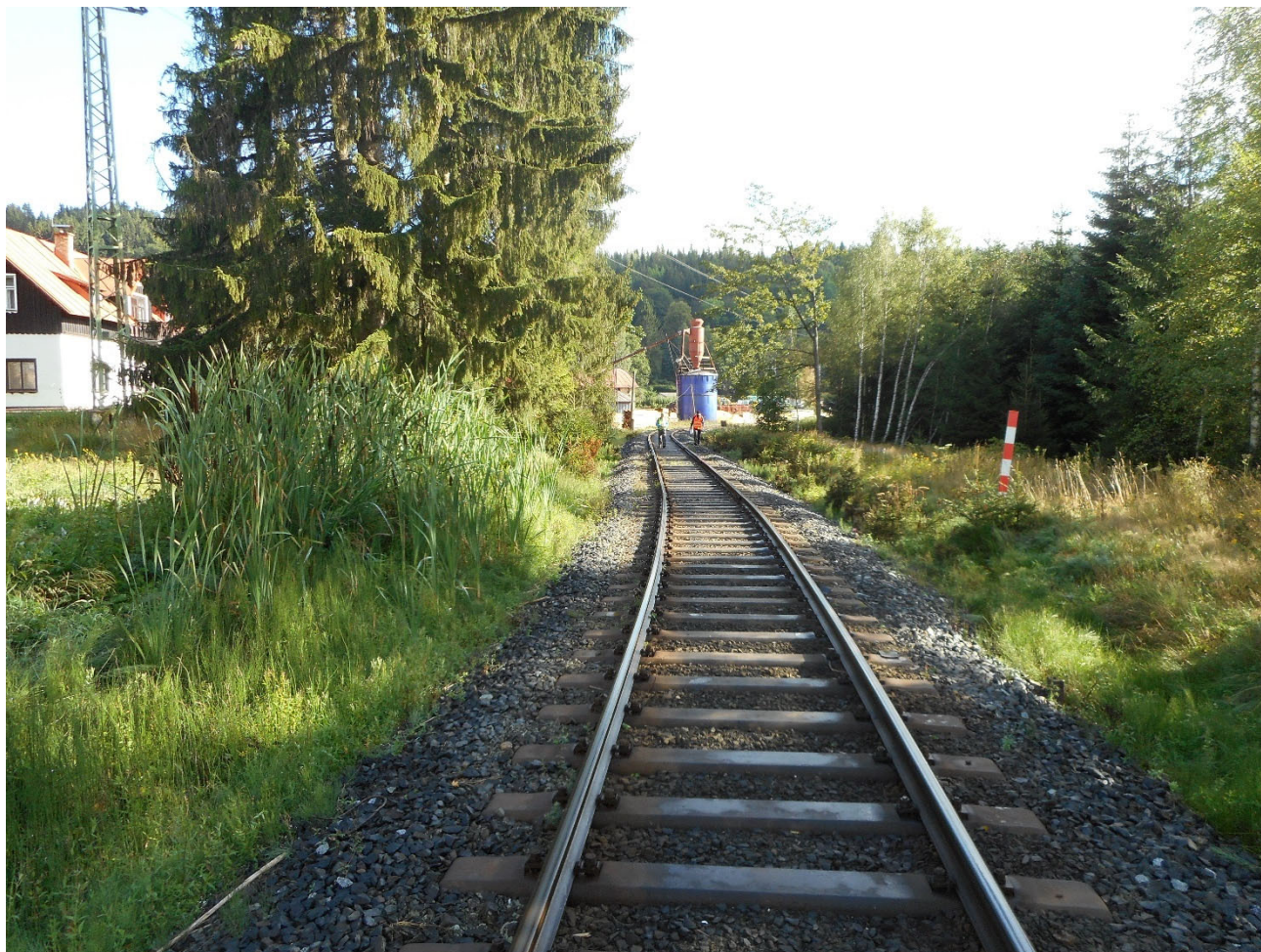
Obr. č.9: Zanesené příkopy v km 33,800 – pohled po směru staničení
