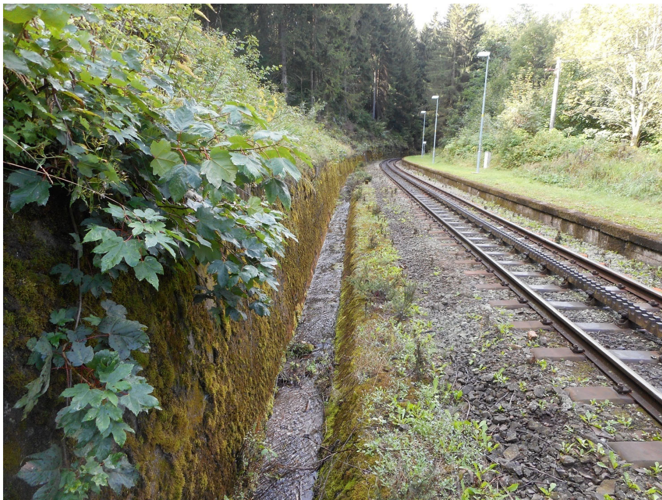
Obr. č.8: Odvodnění betonovým rigolem v zast. Kořenov-zastávka – pohled proti směru staničení
